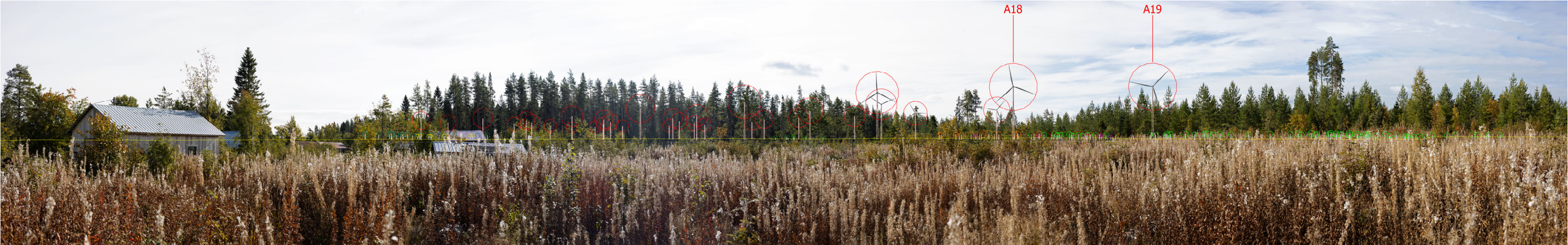
Kuva 14. 180 asteen havainnekuva Mattilanperästä. Etäisyys lähimpään Verkasalon voimalaan 2,1 km. Verkasalon tuulivoimaloiden roottoriympyrät korostettuna punaisella. Lähimmät Verkasalon tuulivoimalat on osoitettu numeroilla. Toiminnassa olevat lähialueiden voimalat korostettu Kytölä sinisellä, Mutkalampi kirkkaan vihreällä, Pajukoski keltaisella, Saarenkylä tummansinisellä, Puutikankangas tummanvihreällä ja Kaukaisenneva pinkillä. Suunnitteilla olevat lähialueiden voimalat korostettu Pajukoski 2 tummanvihreällä, Malakankangas oranssilla, Hangaskurunkangas turkoosilla ja Kaukasen laajennus ruskealla.
