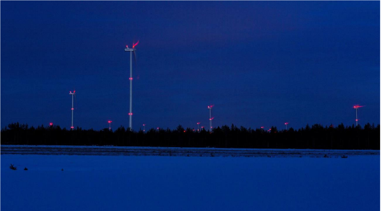
Kuva 69. Kiinteät punaiset lentoestevalot pimeällä. (Kuva: FCG)
