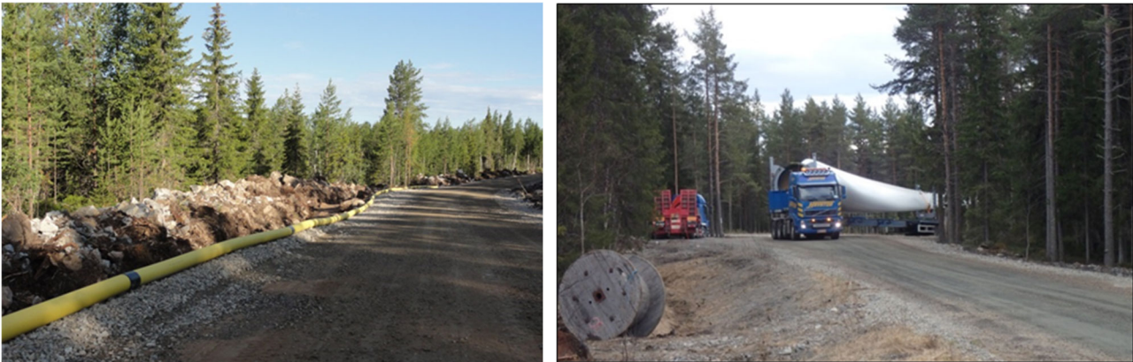
Kuva 73. Vasemmalla kuvassa on esimerkki tuulivoimapuiston rakennus- ja huoltotiestä. Teitä käytetään muun muassa betonin, soran ja voimaloiden komponenttien kuljetuksiin sekä tuulivoimapuiston käyttövaiheessa huoltoajoihin. Maakaapeli sijoitetaan ojakaivantoon tien reuna-alueelle. Oikealla kuvassa tuulivoimalan osia kuljetetaan erikoiskuljetuksina. (Kuvat: FCG).
