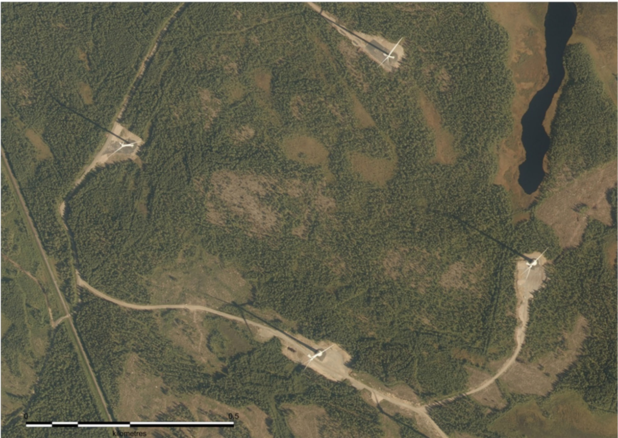
Kuva 65. Ilmakuvassa näkyy toiminnassa olevia tuulivoimaloita. Tuulivoimaloita varten on rakennettu huoltotiet ja nostokentät. Tuulivoimaloiden ympäristössä ja välialueilla aikaisempi maankäyttö on säilynyt ennallaan.
