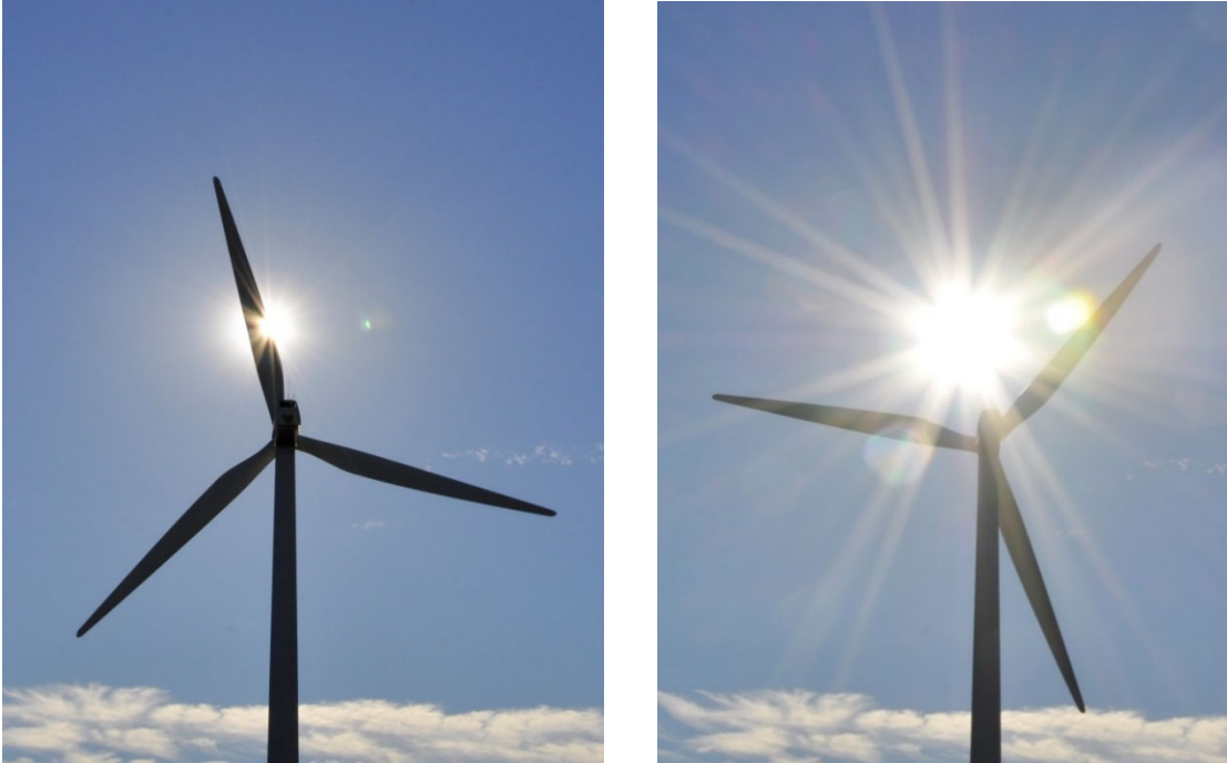
Kuva 47. Tuulivoimaloiden lavat aiheuttavat pyöriessään vilkkumista ja varjon välkkymistä aurinkoisella säällä.
