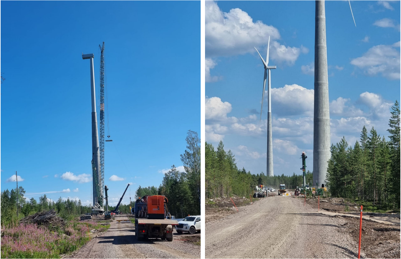
Kuva 66. Vasemmalla kuva tuulivoimalan pystytysvaiheesta ja oikealla kuva käyttövalmiista voimaloista (Kuvat: FCG).
