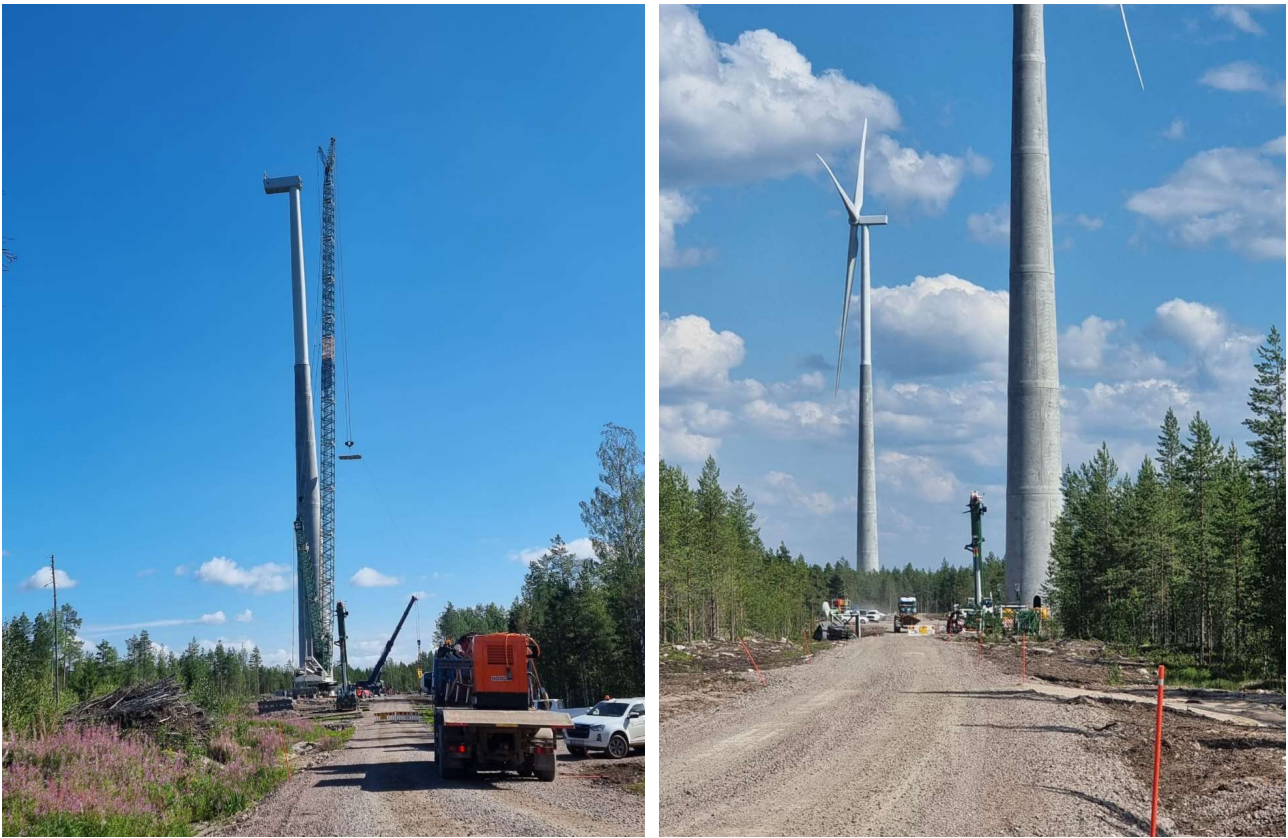
Kuva 68. Vasemmalla kuva tuulivoimalan pystytysvaiheesta ja oikealla kuva käyttövalmiista voimaloista (Kuvat: FCG).
