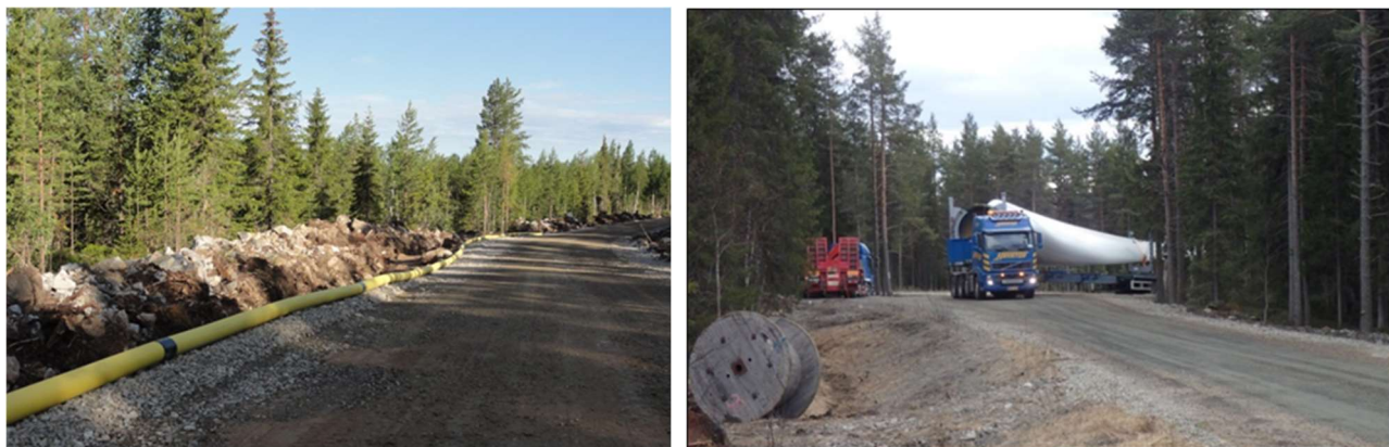
Kuva 75. Vasemmallä kuvassa on esimerkki tuulivoimapuiston rakennus- ja huoltotiestä. Teitä käytetään muun muassa betonin, soran ja voimaloiden komponenttien kuljetuksiin sekä tuulivoimapuiston käyttövaiheessa huoltoajoihin. Maakaapeli sijoitetaan ojakaivantoon tien reuna-alueelle. Oikealla kuvassa tuulivoimalan osia kuljetetaan erikoiskuljetuksina. (Kuvat: FCG).
