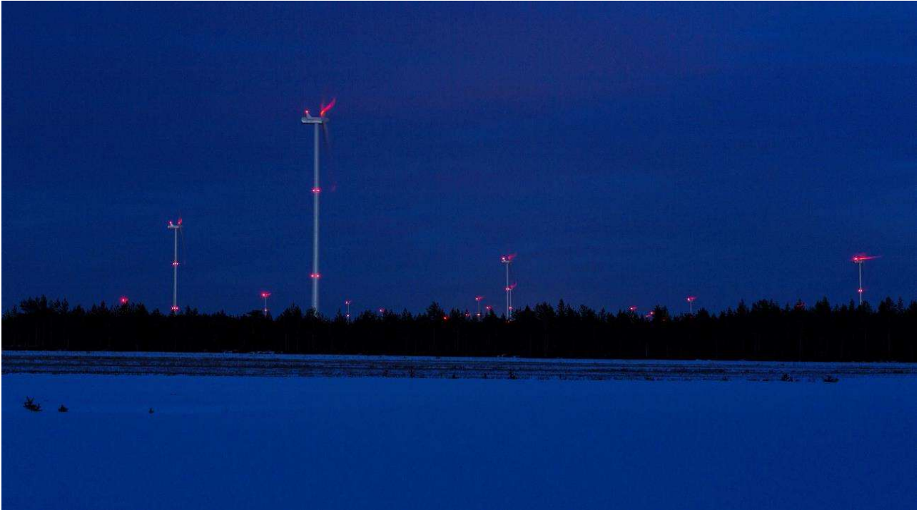
Kuva 71. Kiinteät punaiset lentoestevalot pimeällä. (Kuva: FCG)
