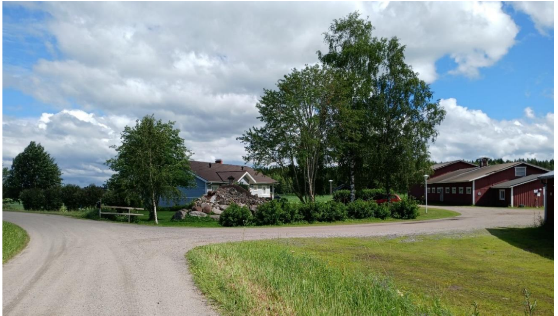
Kuva 63. Näkymä talonpoikaistilalta kohti hankealuetta. Miehennevan tuulivoimalan turbiinit jäävät suurelta osin piiloon puuston ja rakennusten taakse (E.K.).
