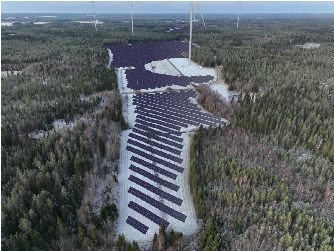
Kuva 30. Havainnekuva aurinkovoimaloista ilmakuvassa (kuva: Eolus).
